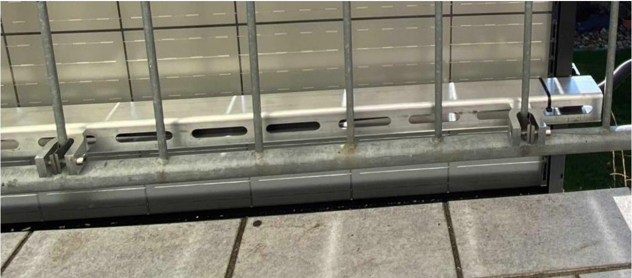
Abbildung 10/ Montageschiene an Spezialklemme
