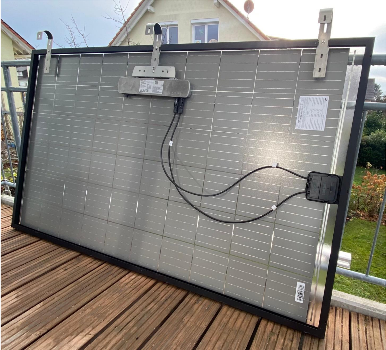
Abbildung 7/vorbereitetes Solarmodul mit 3 Befestigungsbügel und Wechselrichter
