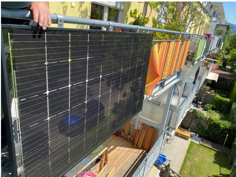
Abbildung 18/Ansicht von außen
