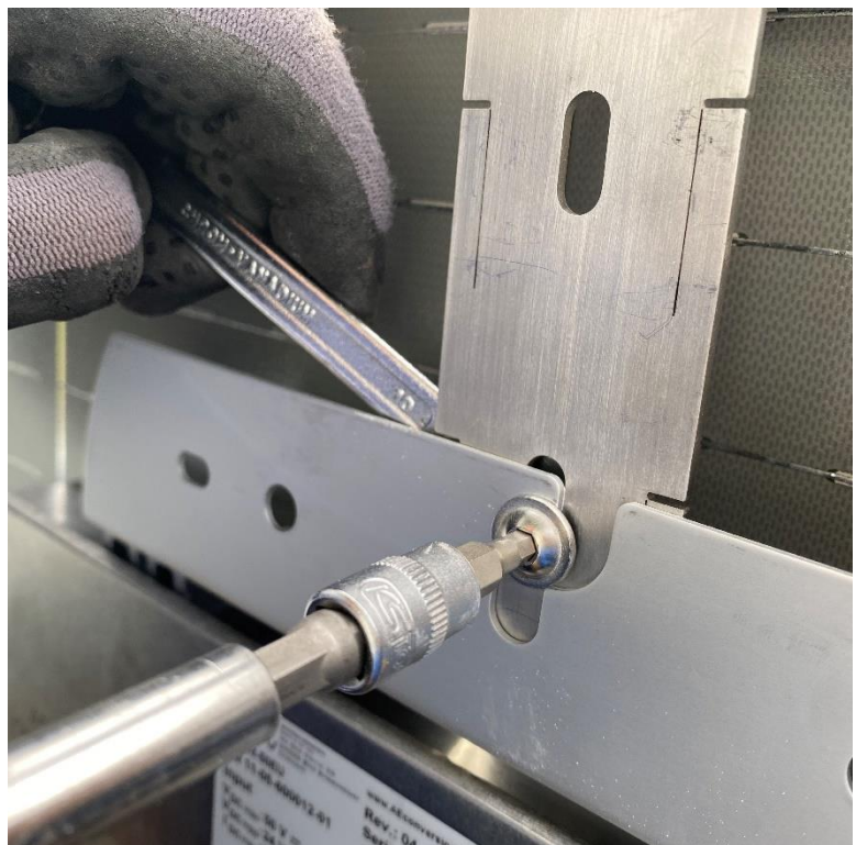
Abbildung 6/Wechselrichter am SOLAR-HOOK Befestigungsbügel anschrauben
