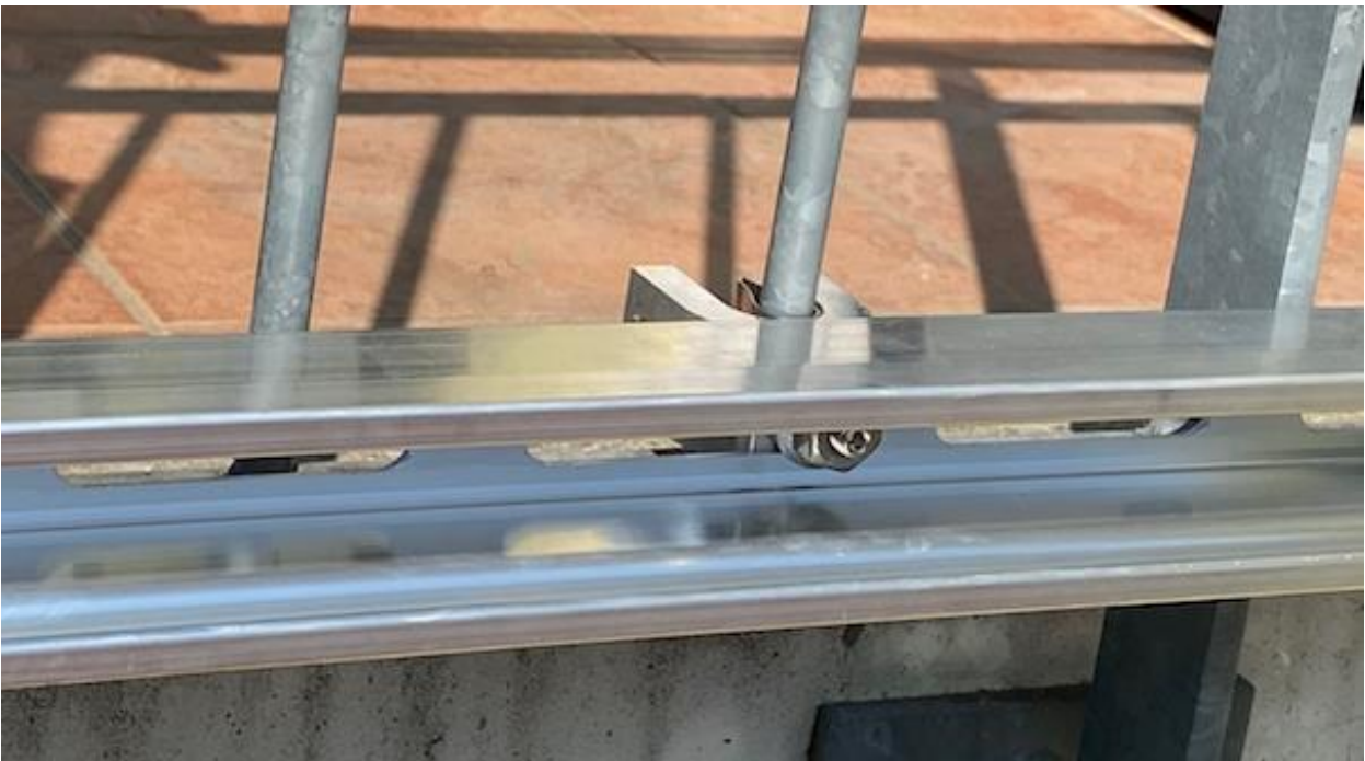
Abbildung 11/Montageschiene und Spezialklemme von außen
