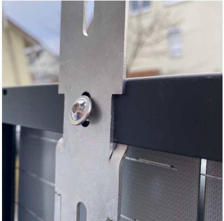
Abbildung 5/locker angesetzte Schraube M6 kurz
